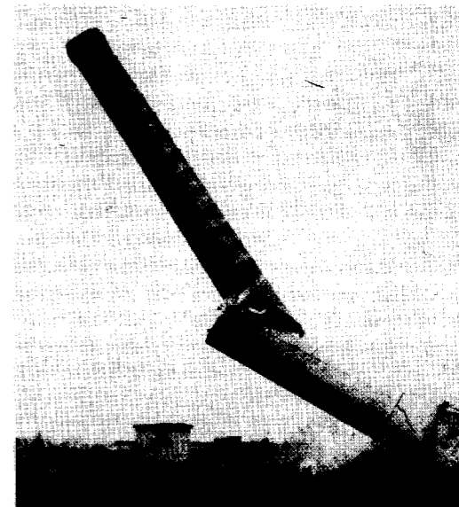
Figura 10 Una chimenea, al caer, a menudo no es lo suficientemente fuerte como para proporcionar la aceleración tangencial de gran radio que se necesitaría si todo el objeto fuese a girar como un cuerpo rígido con aceleración angular constante. Para una descripción completa de este fenómeno, véase "More on the Falling Chimney", por A. A. Bartlett, The Physics Teacher , septiembre de 1976, pág. 351.
