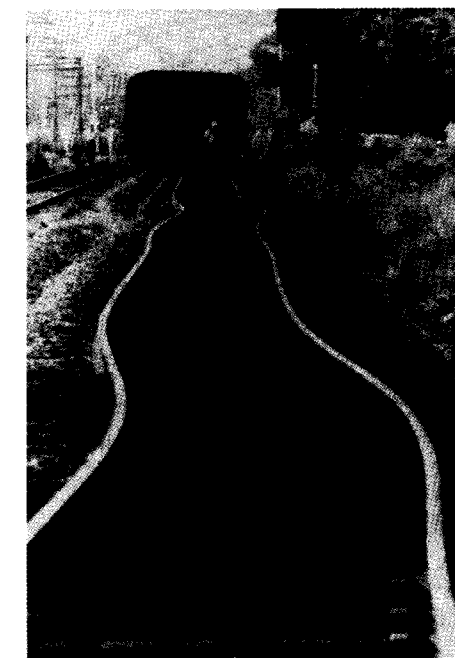
Figura 6 Deformación de las vías de ferrocarril debida a la dilatación térmica en un día muy caluroso. Las juntas de expansión entre los rieles de la vía pueden evitar esta deformación.
